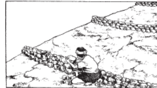
Muro de piedras
